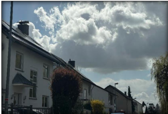
Abbildung 17 EFH; Gielsdorf; Foto: wärmelokal
