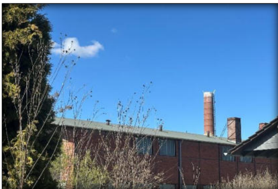
Abbildung 23 Industrieunternehmen; Witterschlick; Foto: wärmelokal
